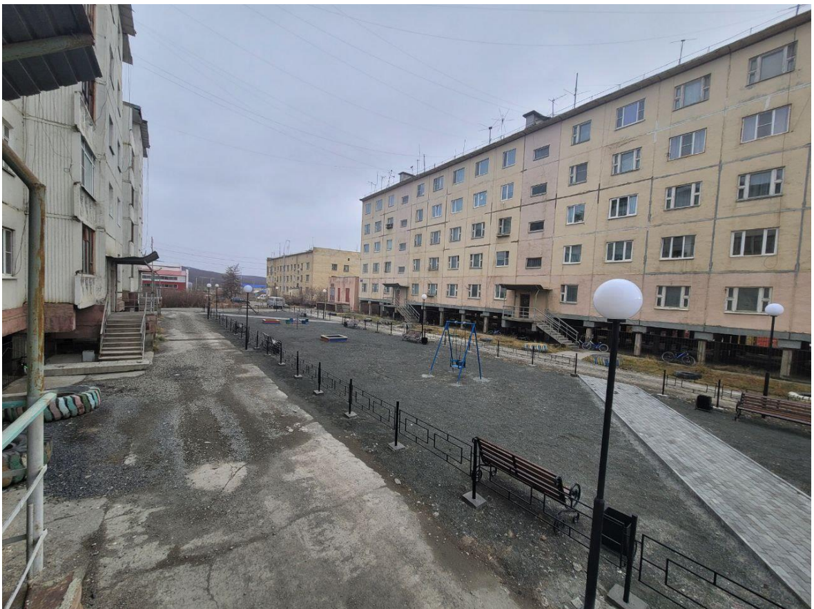
6. В целях благоустройства дворовой территории пгт. Провидения, ул. Эскимосская, д.1 осуществляется доставка материалов.
