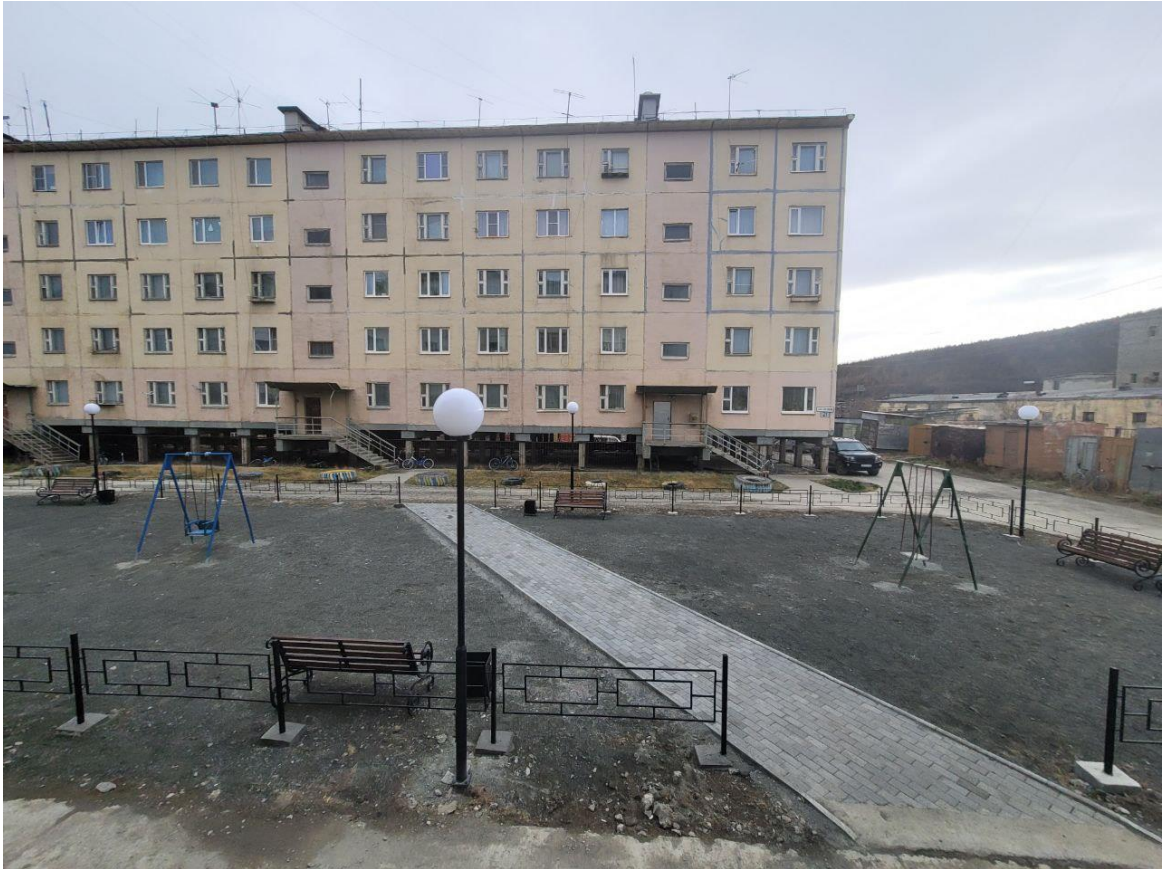
5. г. Билибино, ул. 30 лет Советской Чукотки д. 19 – д. 21. Введена в эксплуатацию
